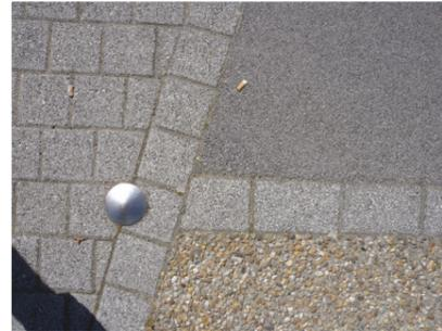
L'enrobé marque la bande passante, la partie en béton désactivée le seuil et les pavés renforcent les intersections
